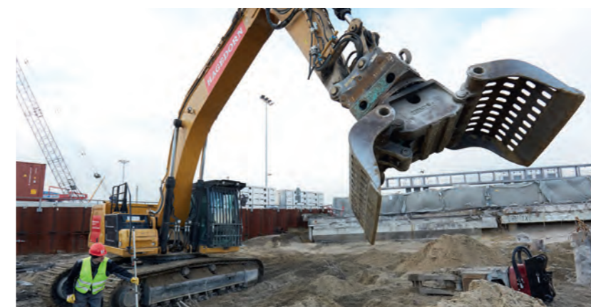
Herausforderungen: Präzision, Professionalität und Umsicht bei Bauarbeiten im laufenden Verkehr
