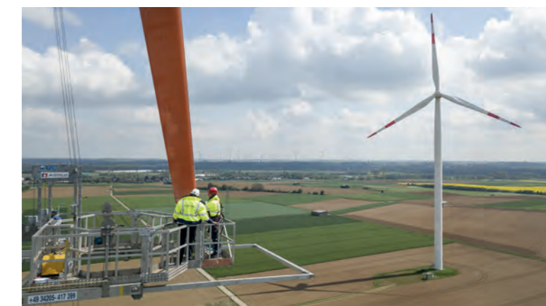
Auf der sicheren Seite: Durch regelmäßige Wartung werden größtmögliche Erträge garantiert.
